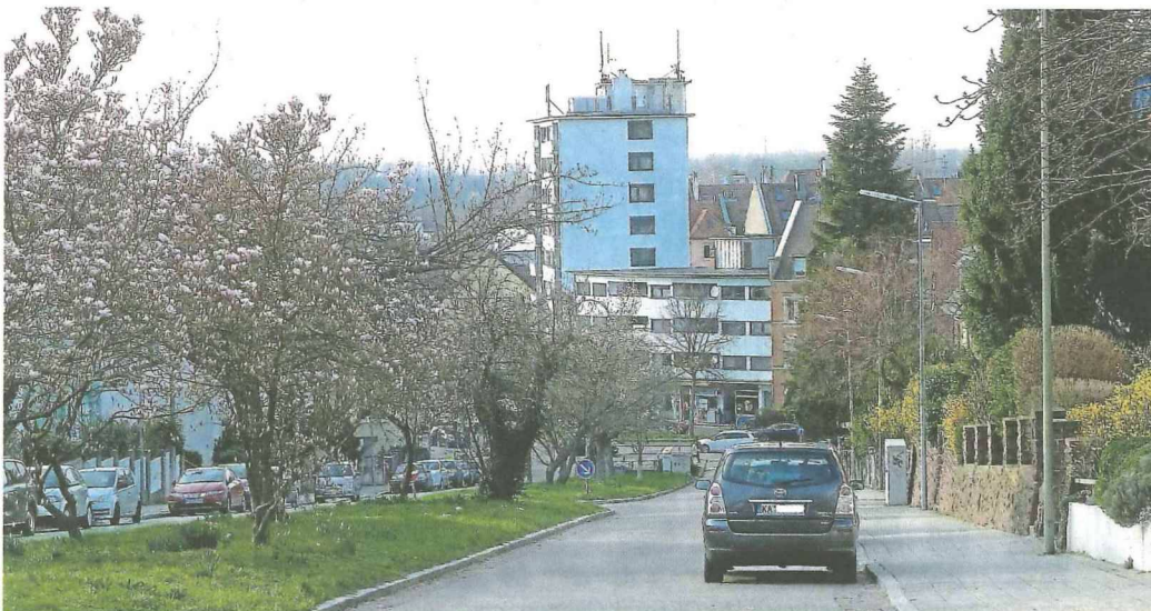
Bergbahnstraße von der Talstation aus gesehen. Fotos: esser/ruf & partner
